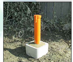
Pose de piézomètre
